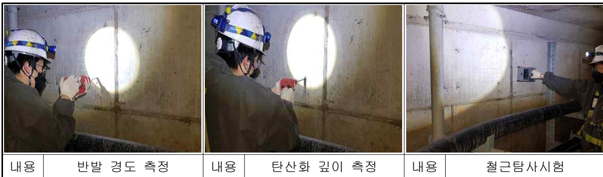
【사진 5.17】 신덕은문산 재료시험 전경
